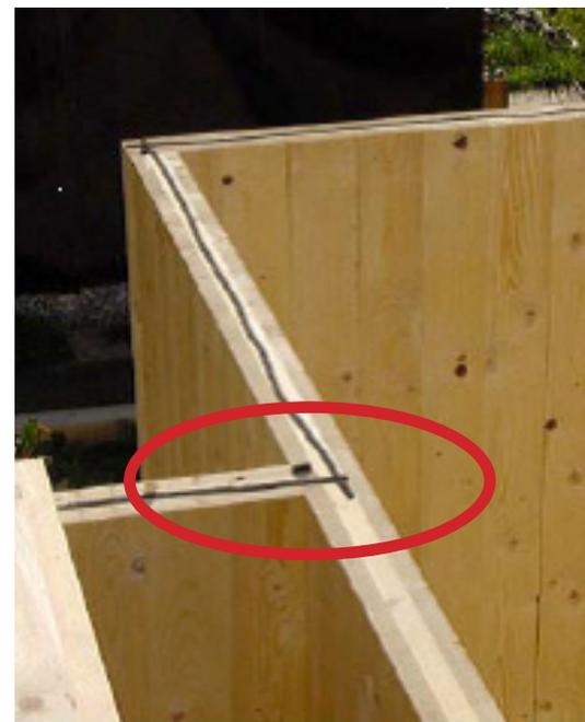
Raccord entre mur longitudinal et mur transversal :
