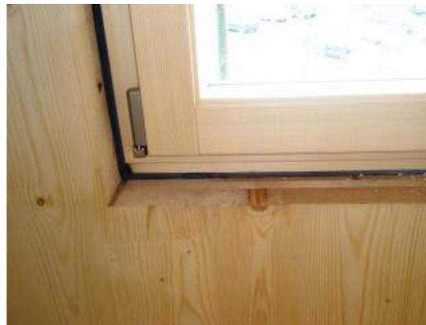
Raccord avec un cadre de fenêtre inséré dans le panneau :
