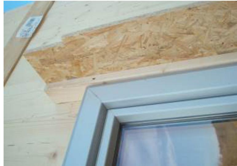
Raccord avec un cadre de fenêtre posé sur le panneau :
