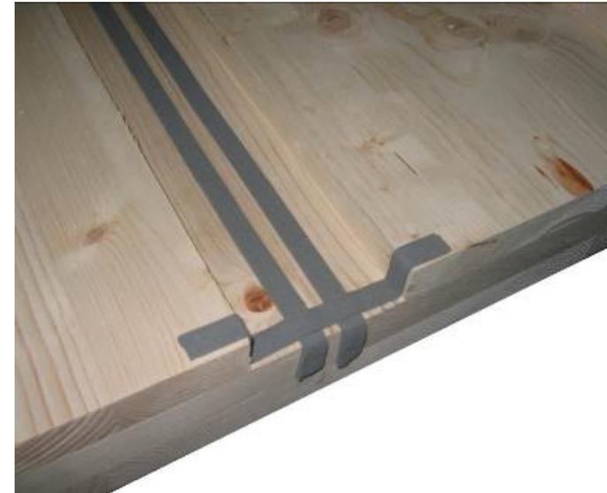
Raccord avec planche de jointure (planche de liaison) :
