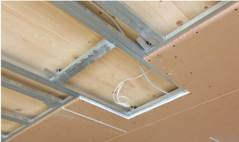
Abbildung 41: Deckensystem mit Schwingbügel und GKF mit guten Schallschutzeigenschaften,
