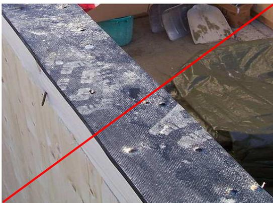
Abbildung 65: Unzulässige Befestigung des elastischen Lagers mit Nägeln
