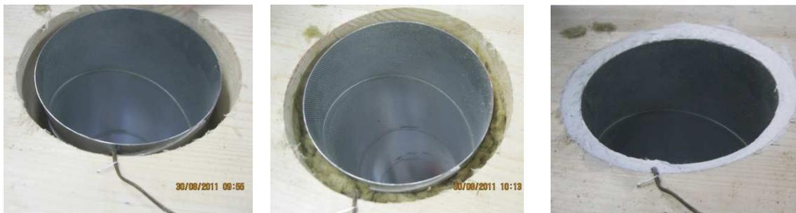
Abbildung 90: Dämmung des Ringspalt zwischen Lüftungsrohr und Holzbauteil mit Steinwolle (Mitte), Anbringen einer intumeszierenden Brandschutzmasse mit einer Tiefe von ca. 15 mm (rechts)
