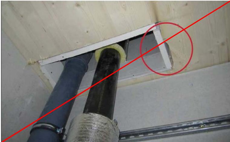
Abbildung 80: fehlerhafte Ausführung: Nicht vollflächiger Einbau der Leibungsverkleidung
