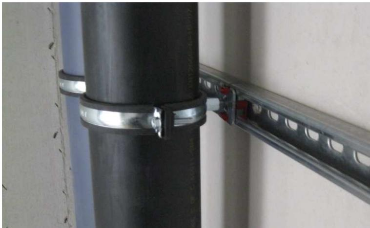
Abbildung 81: Schallschutztechnische Entkoppelung der Rohre
