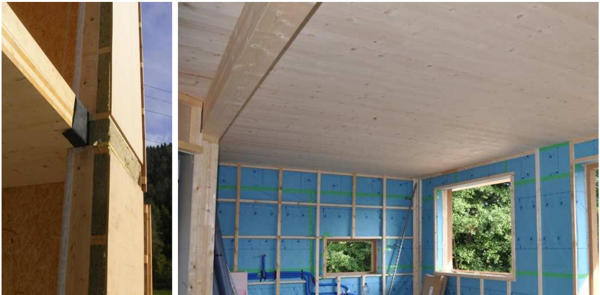
Abbildung 2: Kombination Brettsperrholzdecke mit nicht tragender Außenwand in Holzrahmenbauweise
