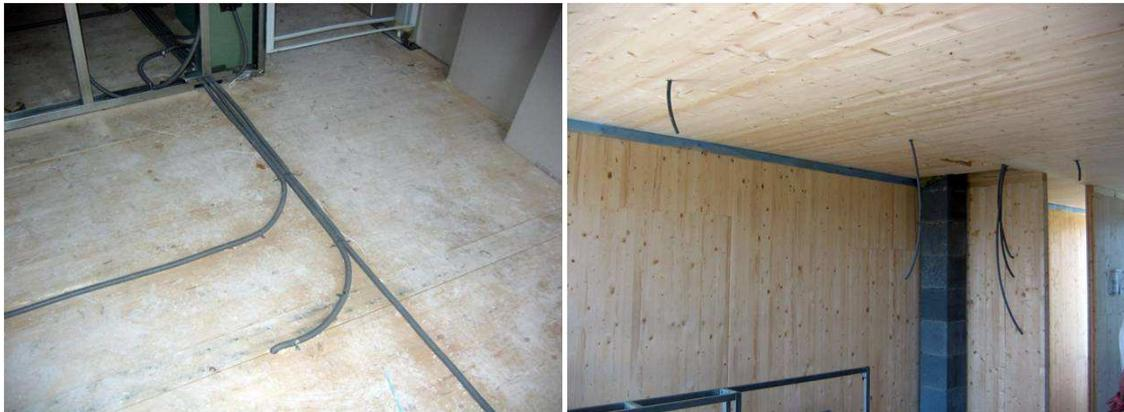
Abbildung 37: E-Leitungsführung bei sichtbarer Brettsperrholzdecke ist luftdicht auszuführen
