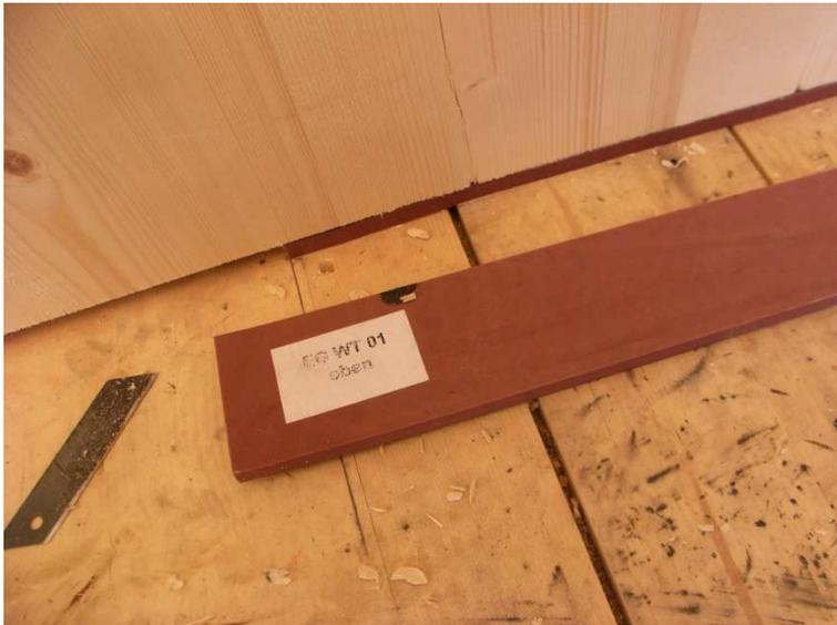
Abbildung 64: Sylomerelager im Auflagerbereich zur Entkoppelung
