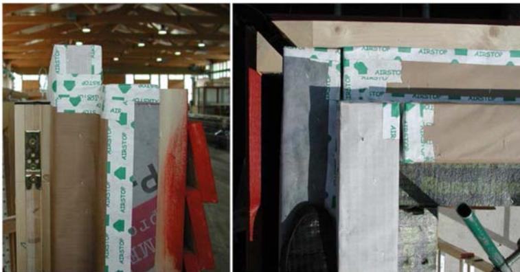
Abbildung 55: Außenwanddecke: links Vorfertigung (Ansicht); rechts Montage (Draufsicht)
