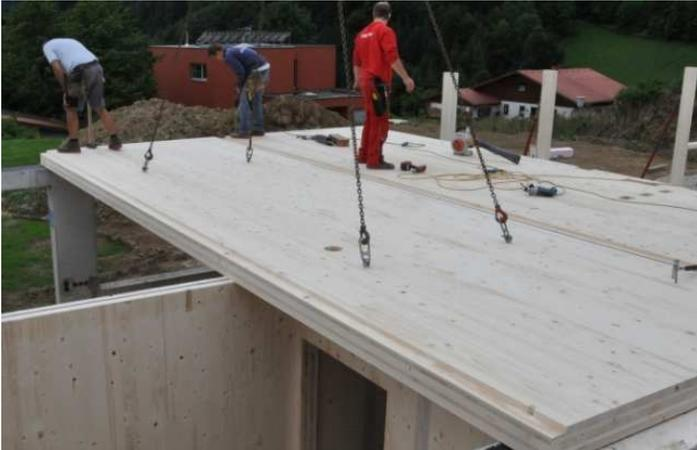
Abbildung 43: Durchlaufdecke benötigt bei Trennwänden eine Abhängung zur Verhinderung der Schall-Längsleitung
