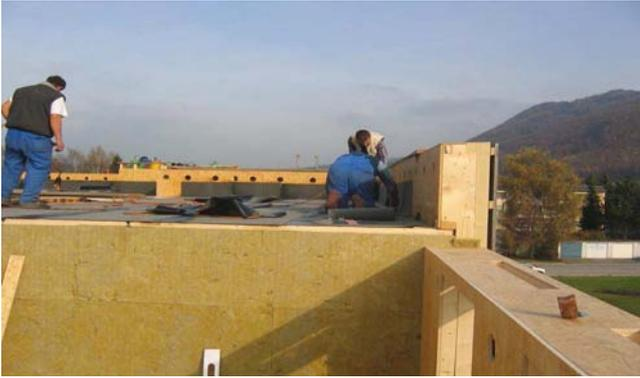
Abbildung 46: Dampfbremse (Bitumenabdichtung) am Flachdach als Bedarfswitterungsschutz
