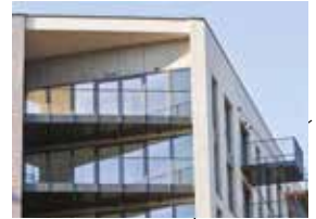
Bridport House, London 8 Stockwerke: „Das höchste in London errichtete Gebäude aus CLT entstand in nur 12 Wochen“
