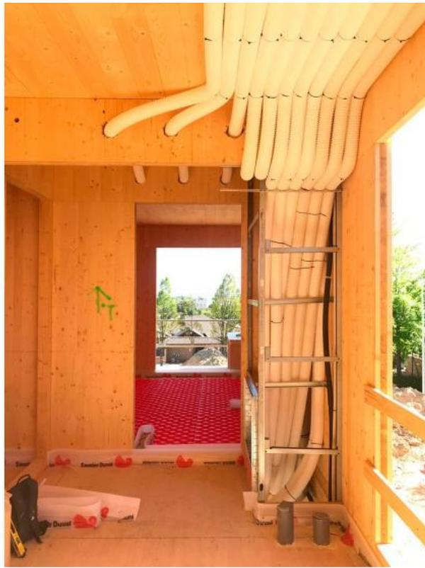
Foto 19. Detalle de colocación del sistema de ventilación.
