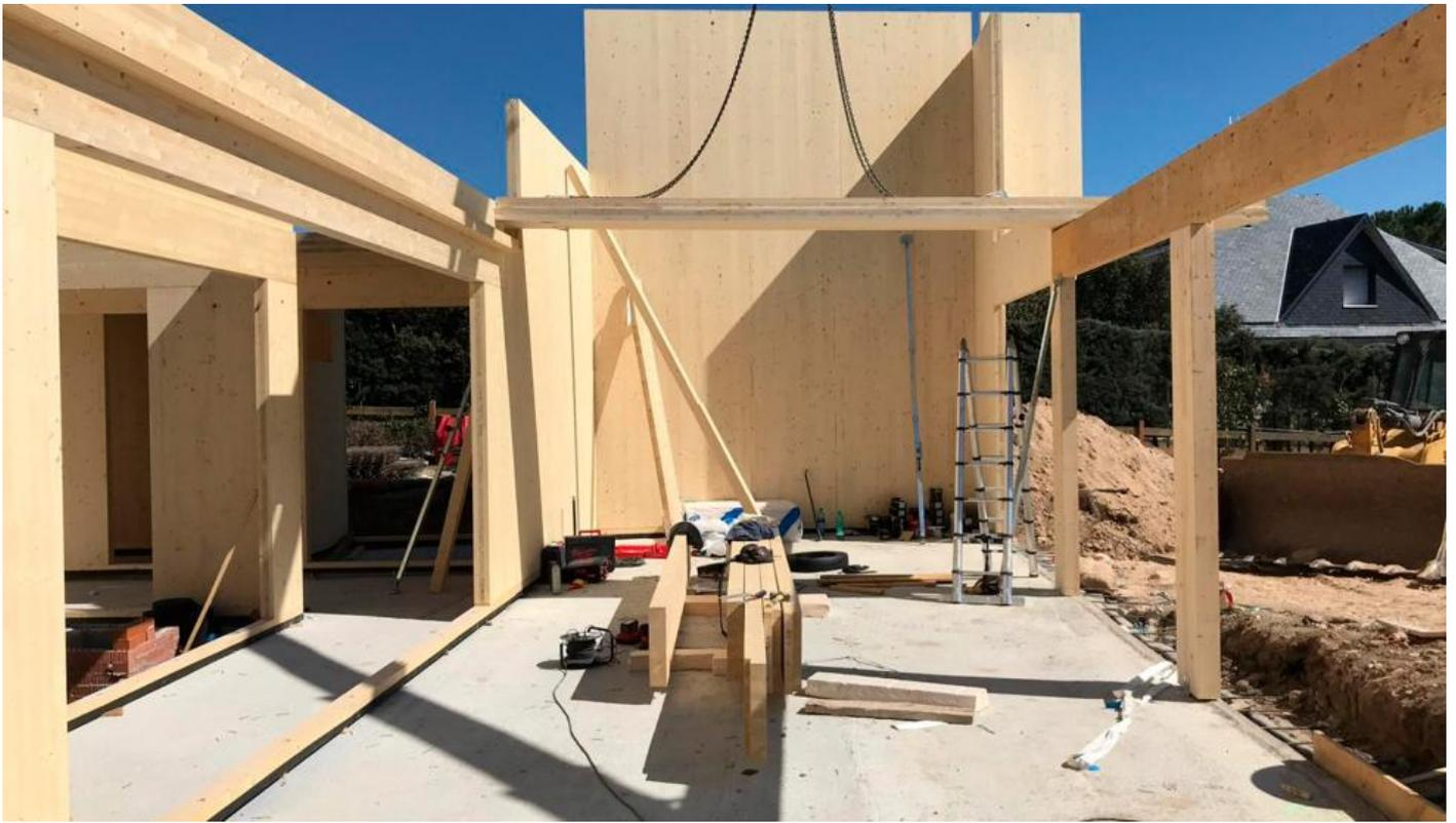
*Foto 7. Montaje de la estructura atado con vigas.*
