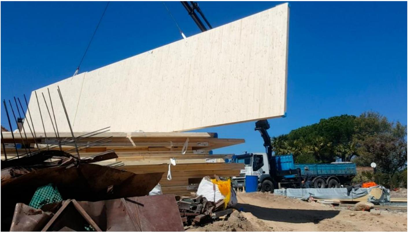
*Foto 5. Colocación de panel con grúa.*
