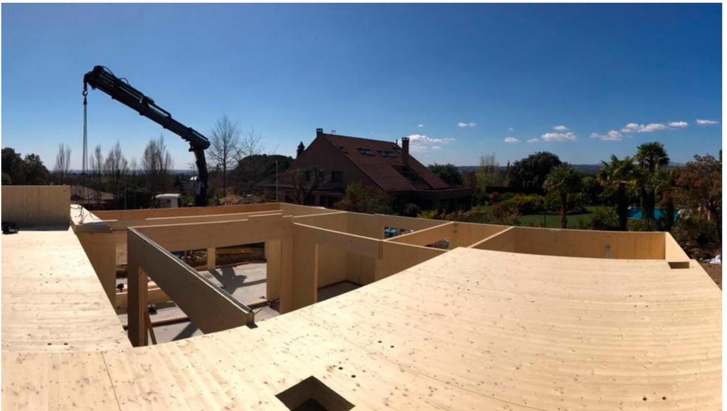
*Foto 8. Montaje de la estructura y rigidizacion con forjados.*
