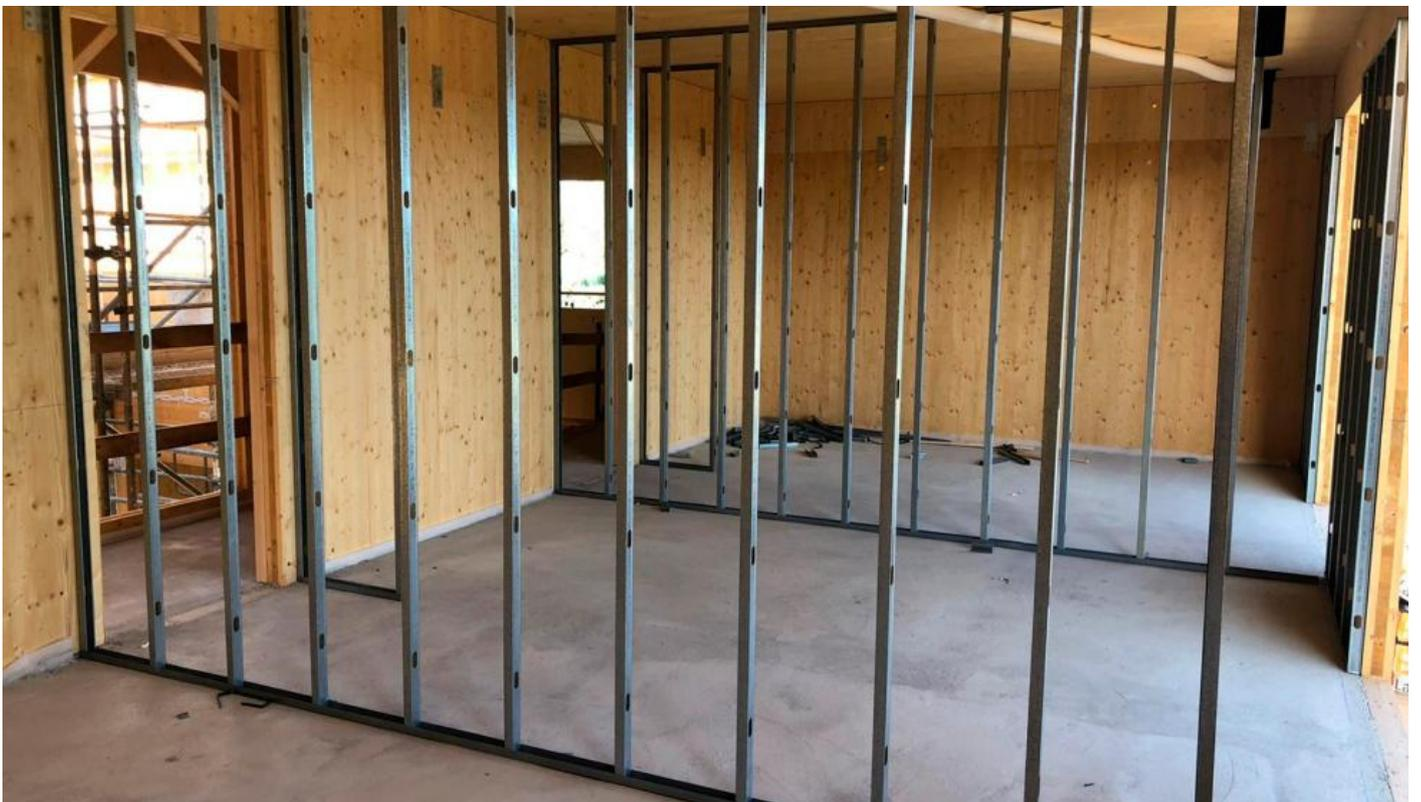
Foto 16. Detalle de colocación de pladur.
