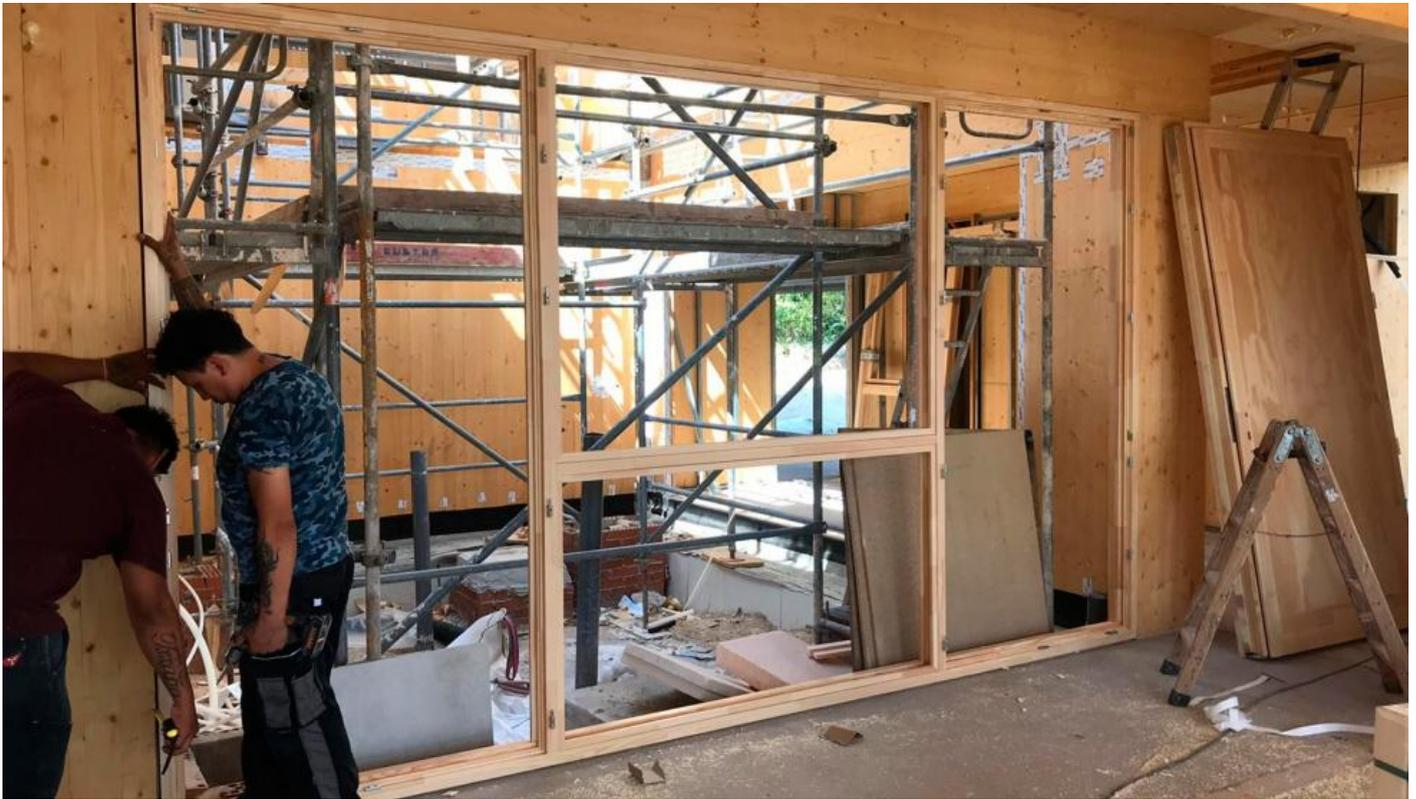
*Foto 13. Colocación de ventanas.*
