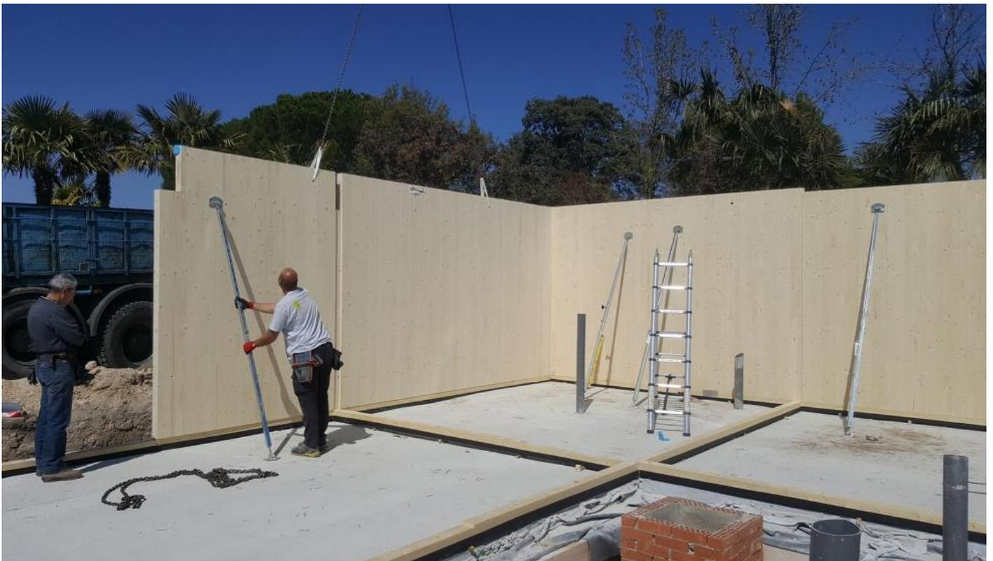
*Foto 6. Montaje de la estructura y apeos.*
