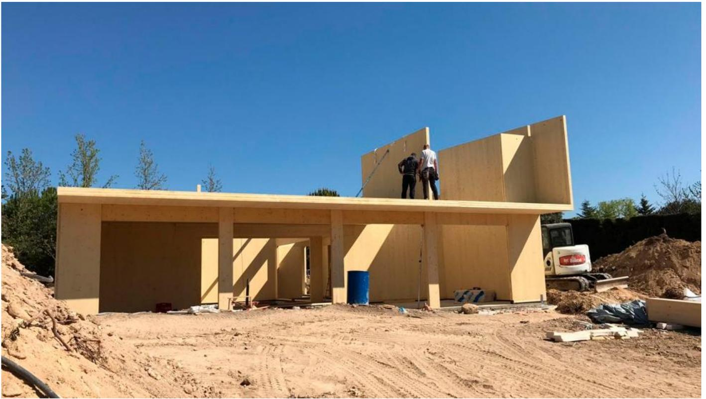
*Foto 9. Montaje de la estructura y rigidizacion con forjados.*
