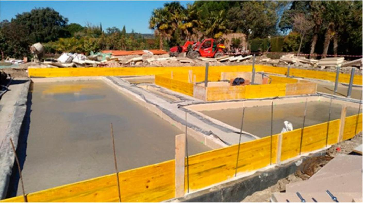
Foto 2. Detalle de cimentación, aislamiento e impermeabilización de Zapatas.
