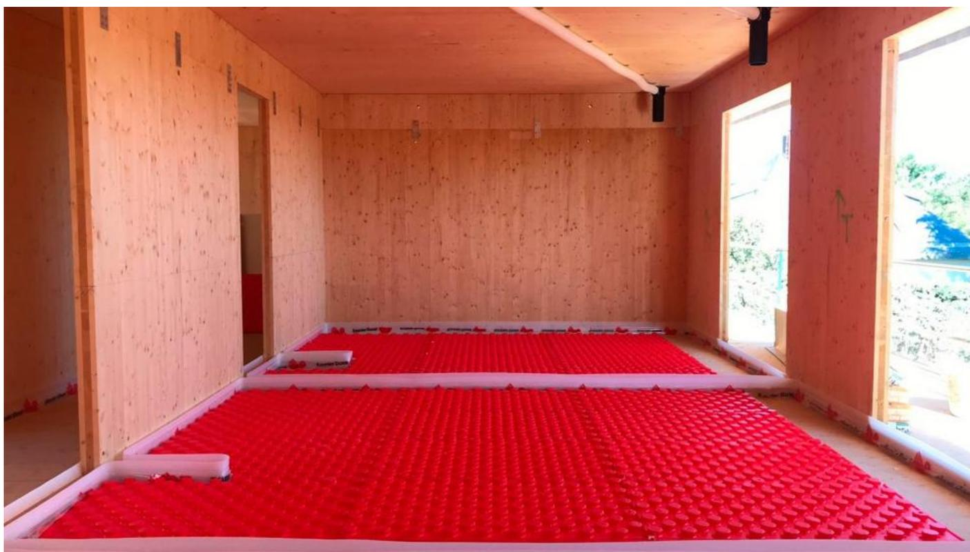
*Foto 18. Detalle de colocación de suelo radiante.*
